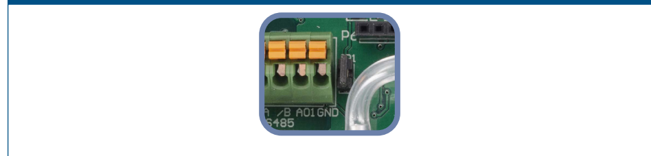
Рис. 5 Соединительная перемычка резистора подключена
